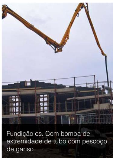
Fundição cs. Com bomba de extremidade de tubo com pescoço de ganço
