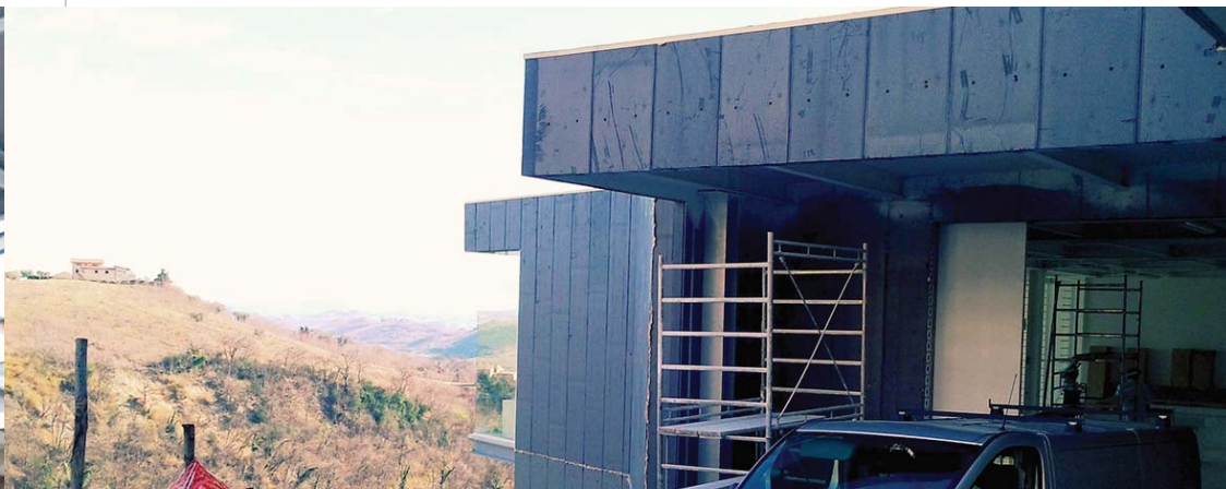
Instalação de divisórias
