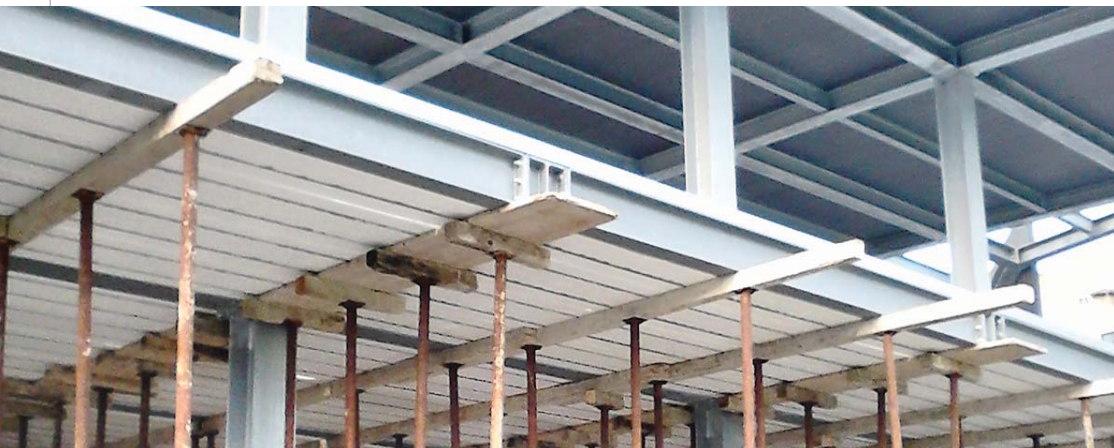
Montagem da moldura
