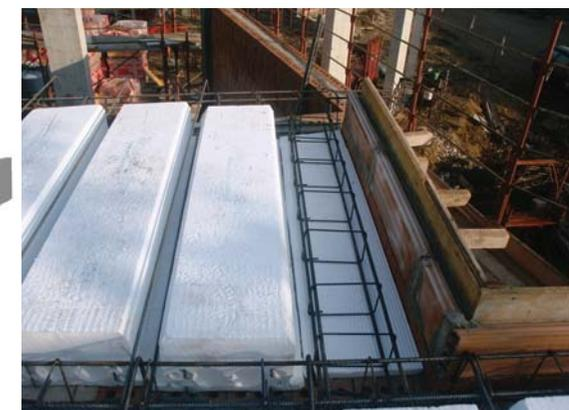
A **POLIARMO** permite ter lajes retas com extremidades perfeitamente paralelas e eliminar os resíduos quase na totalidade, porque permite colocar as lajes lado a lado, até à largura pretendida. Em combinação com o pavimento de cofragem **Plastbau® Metal**, elimina as pontes térmicas sob viga da totalidade da laje de pavimento.
