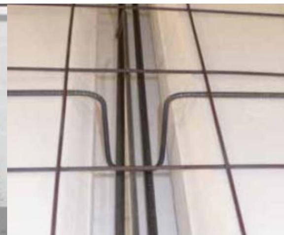
Os suportes de aço Ø6mm são colocados nos espaços entre as lajes de pavimento antes da betonagem, a uma distância de 150cm entre si; os suportes irão sustentar as traves de reforço inferiores, separando-as do fundo do painel e garantindo a cobertura mínima de betão para o reforço.
